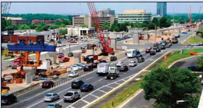
A lo largo de la Ruta 7: La construcción del muelle se lleva a cabo a lo largo de la Ruta 7 en la Intersección de Gosnell/Westpark. Foto por Chuck Samuelson, proyecto del Metrorail de Dulles
