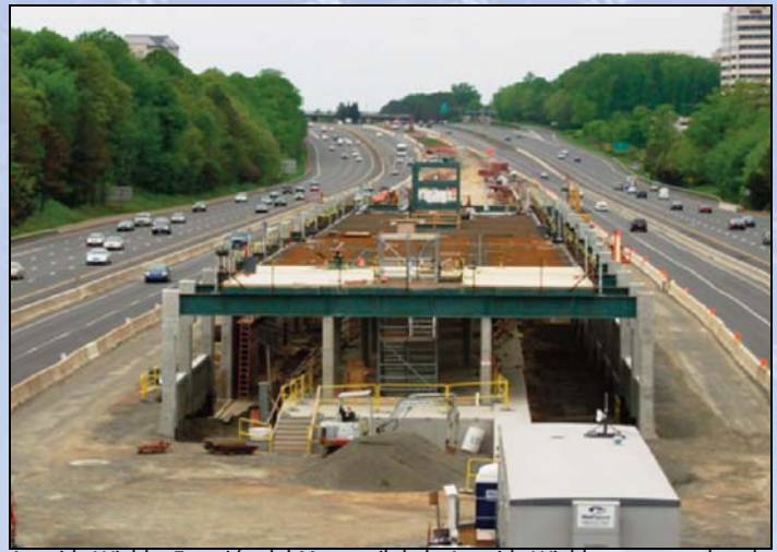
Avenida Wiehle: Estación del Metrorail de la Avenida Wiehle esta completada en 28 por ciento. Foto por Stephen Barna, proyecto del Metrorail de Dulles
