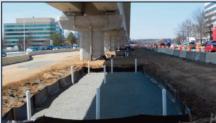
Debajo de Las Vías: Este agujero grande es un construcción de cuenca ocurriendo debajo del carril-guía aéreo en la mediana de Ruta 7 al oeste de Gosnell Road donde las tuberías de desagüe y un base de grava están siendo instalados antes de la colocación del suelo. Foto por Stephen Barna, El Proyecto de Metrorail del Corredor Dulles.
