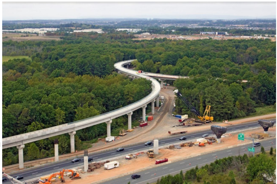
El carril-guía aérea elevada en el extremo norte del aeropuerto internacional Dulles llevará a los trenes hacia y desde el nuevo taller de mantenimiento ferroviario y en la mediana del verde de Dulles, donde los trenes volverán a al grado de balasto. Foto por: Jennifer Alcott, Capital Rail Constructors
