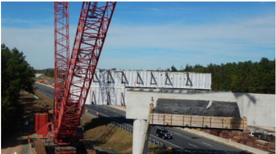
Un lapso de hormigón de gran tamaño (doblada straddle) se construye a lo largo de los carriles hacia el este del Dulles Greenway. Foto por: Jennifer Alcott, Capital Rail Constructors
